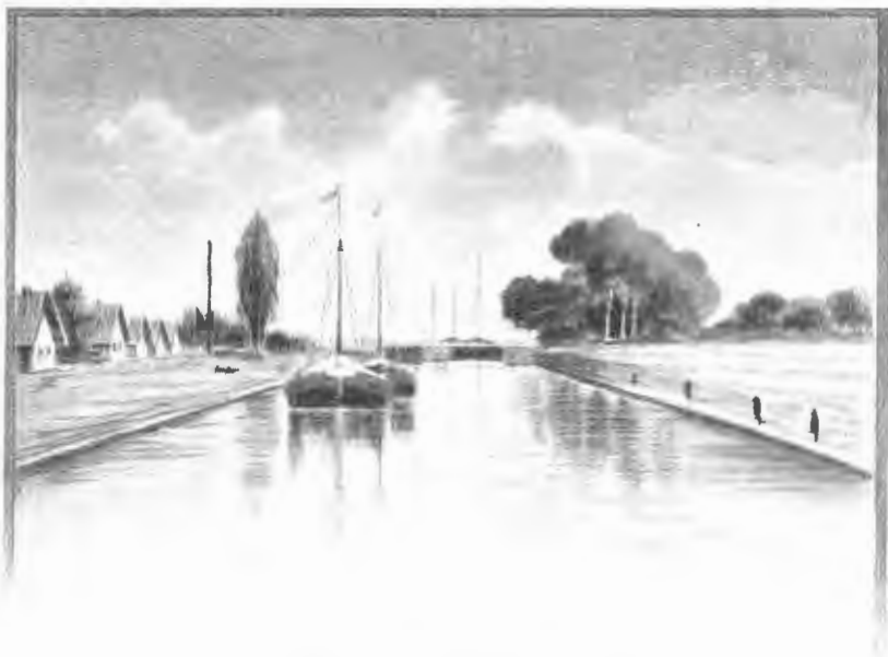
Шлюзъ Польза. (Начало Бѣлозерскаго канала).
